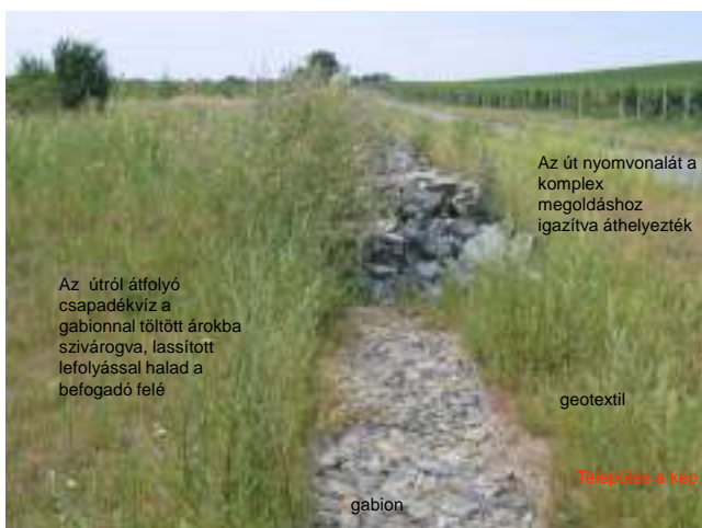
4. ábra: feltöltött vízelvezető árok
