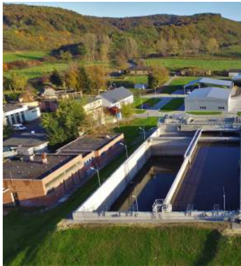
A Cyclator technológiájú ózdi szennyvíztisztító telep
