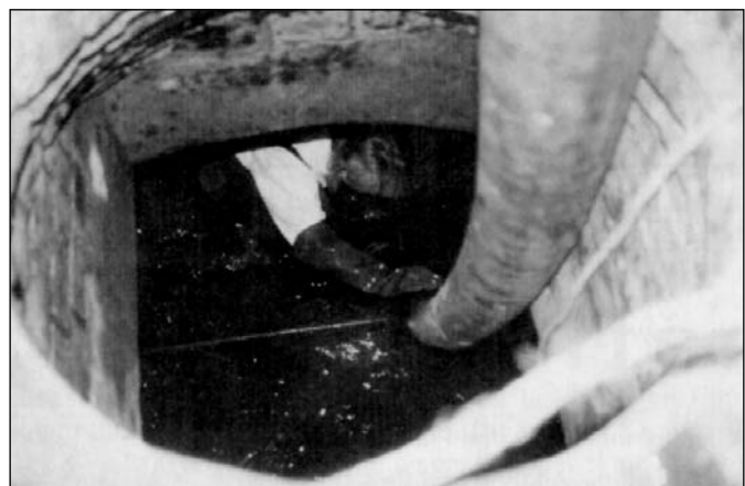
6. kép. Munka a csatornában
