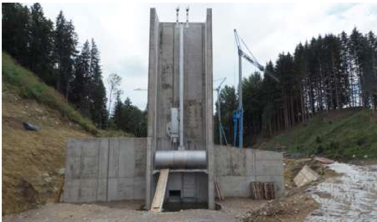
10. ábra A HidroMaxx berendezés beépítése, Sulzberg (Steinhardt GmbH. – referencia videó)
