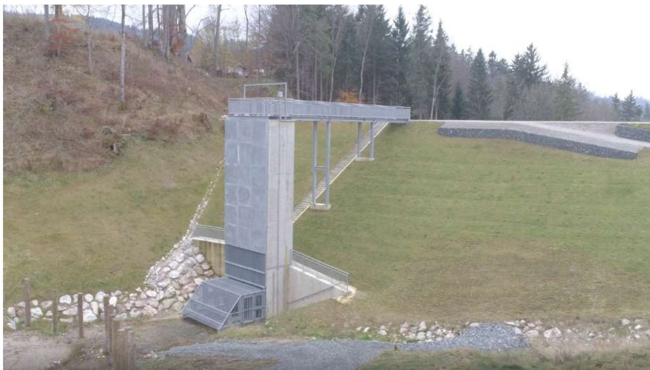
9. ábra Sulzberg - Lefolyás szabályozóval (HidroMaxx típus) ellátott záporvíz tározó (Steinhardt GmbH. – referencia videó)
