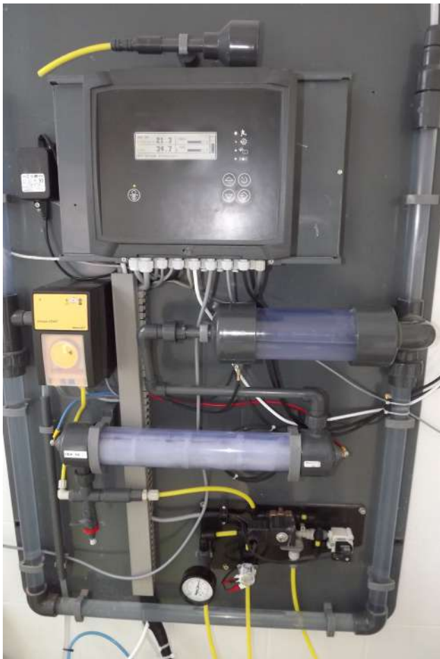
A hypó gyártó berendezés üzeme
