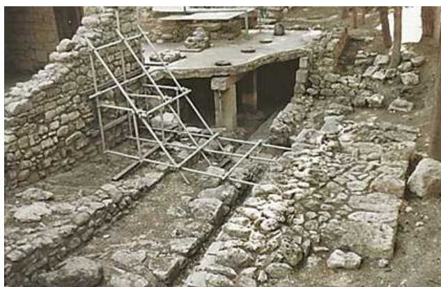
2. kép .Knósszoszi palota szennyvíz elvezető rekonstrukciója (a szerző fotója)
