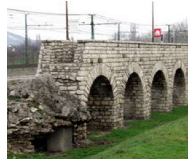
16. kép: Az Aquincumi vízvezeték romj részlete (foto: Kaboldy)
