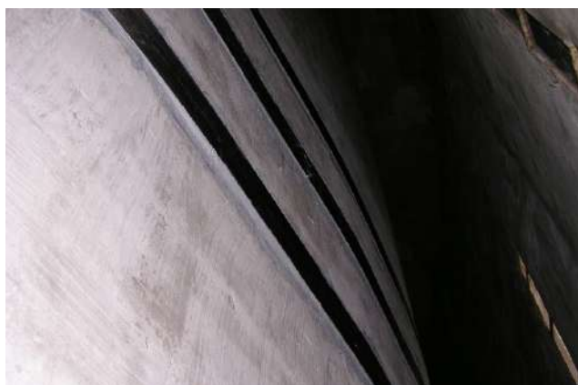
A medence szénszálal megerősítése
