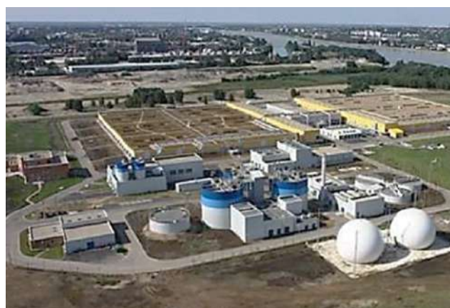
10. ábra Bp. Központiszennyvíztisztítótelepe. (c:1,35mill. LE 350\,000\text{ m}^3/\text{d} )
