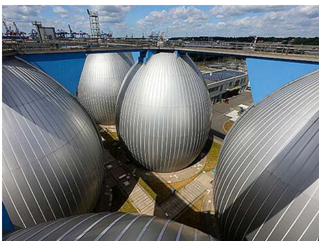
1. ábra Rothasztótornyok a hamburgi szennyvíztisztító telepen.
