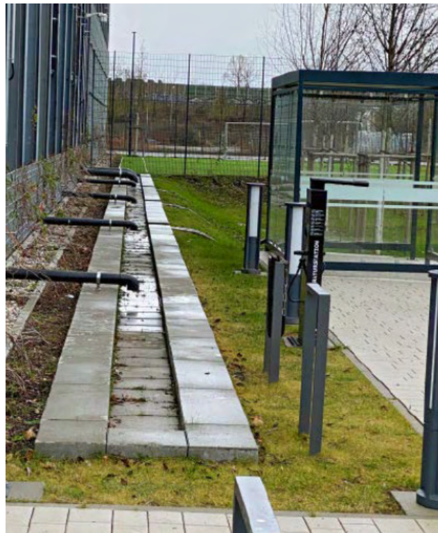
5. ábra: Nagyobb épület tetőfelületének vízvezetése szivárogtatókba
