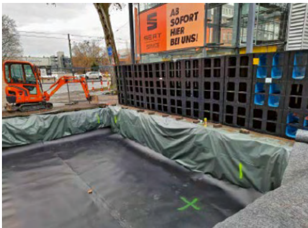
6. ábra: Föld alatti szivárogtatóberendezés építése
