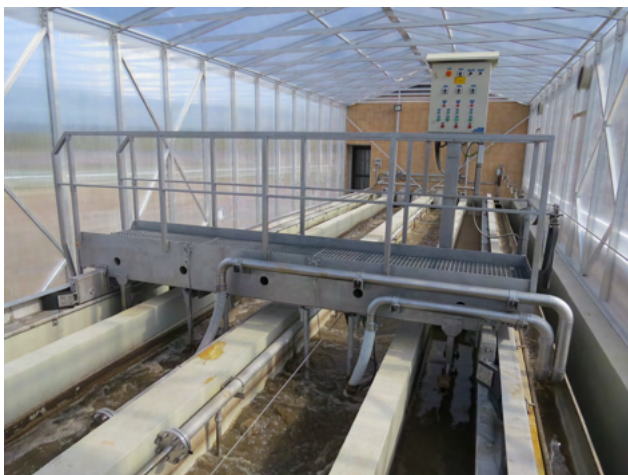
Homok és zsírfogó hosszanti átfolyású iker műtárgyban, zárt térben
