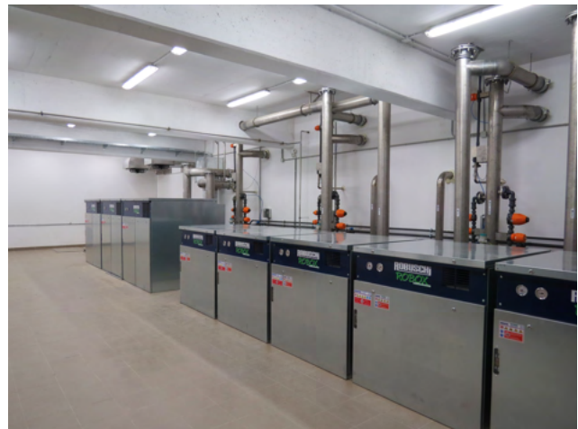
Membrán gépészet: balra: szivattyúház jobbra: biológiai és membrán fúvók
