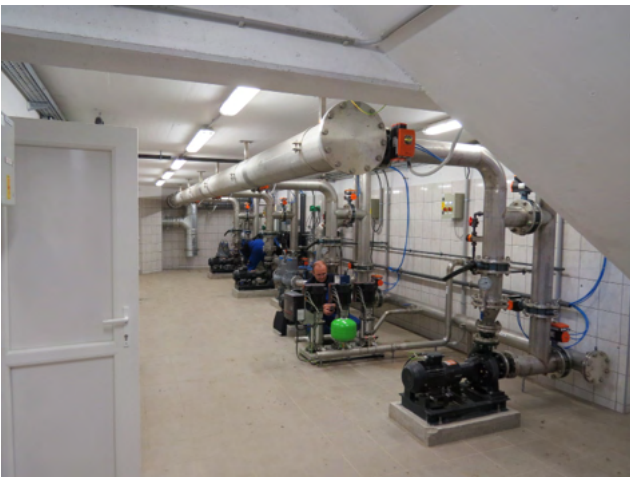
Membrán gépészet: balra: szivattyúház jobbra: biológiai és membrán fúvók
