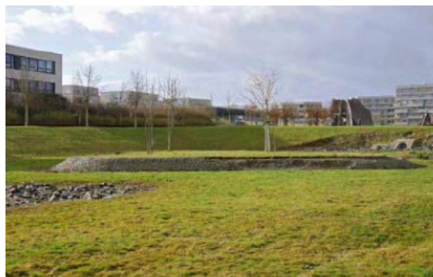
3. ábra: Részben csapadékvíz-tározásra szolgáló szabad terület lakott területen
