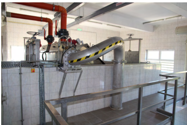
A mechanikai tisztítás berendezései: balra léptető-rács, jobbra forgó-dobszűrő
